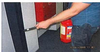
Rys. 7. Sposób uruchomienia gaśnic
